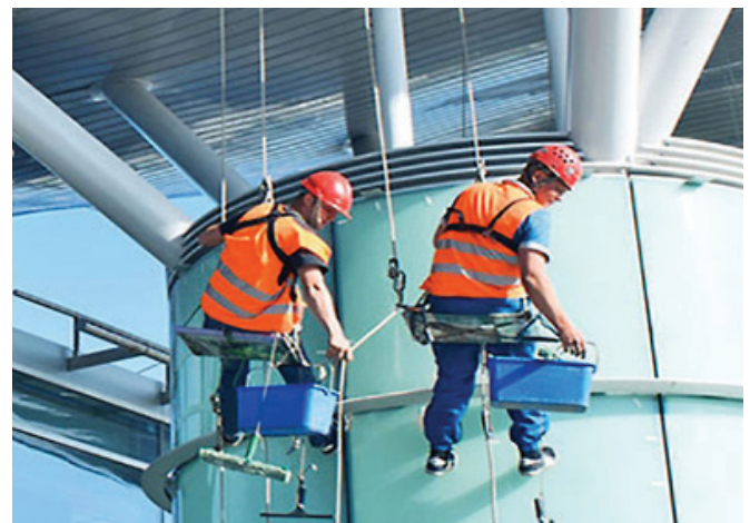
10 Vệ sinh kính và mặt dựng tòa nhà văn phòng tại Bình Dương
