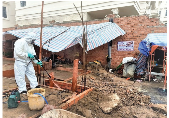
08 Dự án diệt mối công trình biệt thự tại Đà Lạt
